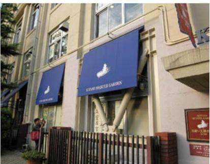
1階部分の耐震補強 改修前の耐震診断により1階にのみ一部ブレースを加えた
