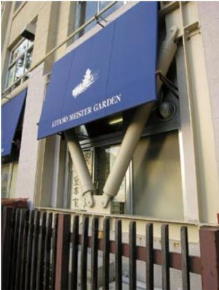
写真5-6 耐震補強ブレース
