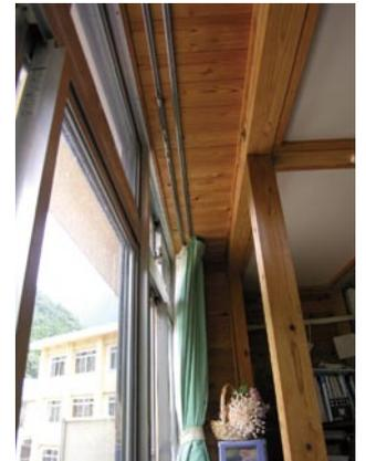
居室は、既存のRC校舎(スケルトン：構造)に対して木造のインフィル(：内装・設備)を挿入する方法で住戸を構成
