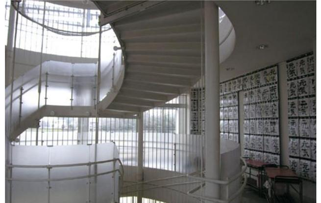
改修前にトイレと階段だった部分の床スラブを撤去し、鉄骨階段を取り付けて軽量化している→トイレは北側へ移設
