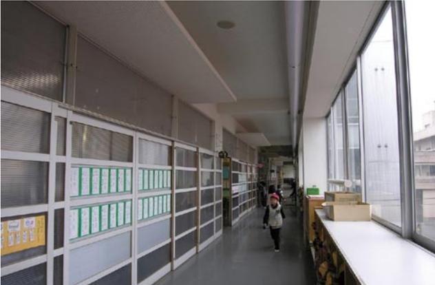
廊下と教室の間の壁は全て撤去され、ポリカーボネートの半透明の引き戸により間仕切られている
