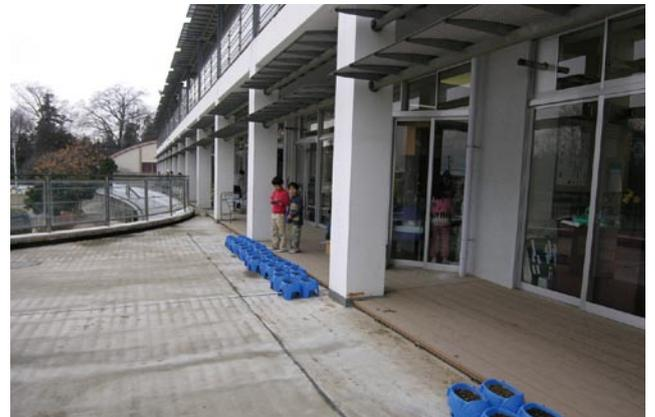
1階の増築部分の屋上はウッドデッキであったが、劣化が激しく、現在は屋根面が露出している
