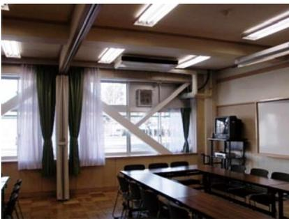
写真5-7 耐震補強ブレース
